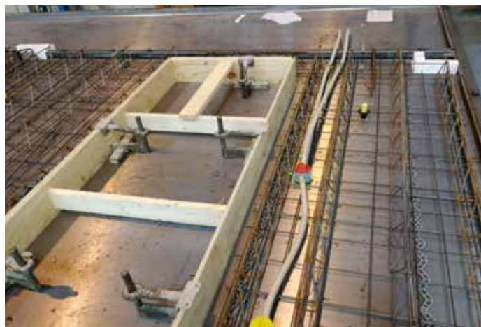
Układanie szalunku i rozmieszczenie puszek instalacyjnych
