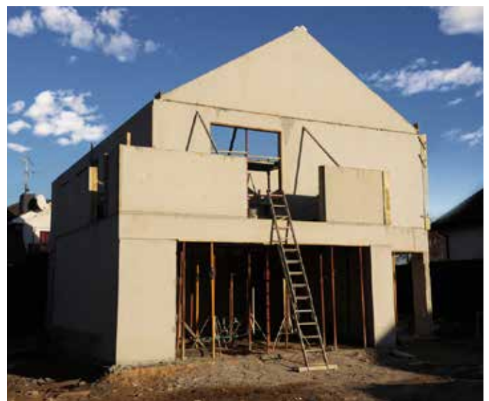
Realizacja projektu domu prefabrykowanego w Skórzewie
