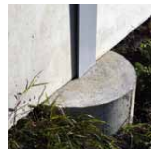
Przykłady osadzenia słupów nośnych.
