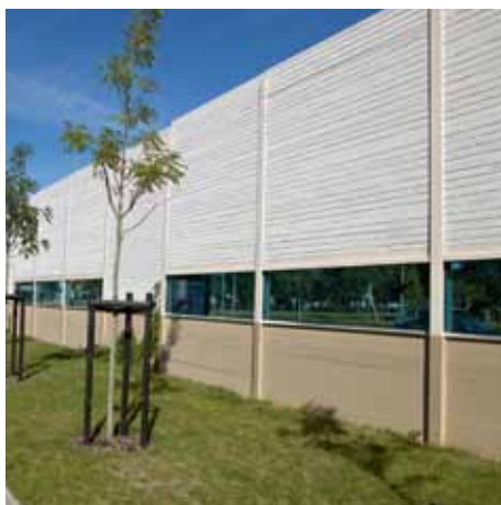
Panele SEA ze strukturą deskowania z wmontowanymi przeszkleciami na wysokości wzroku pieszego.
