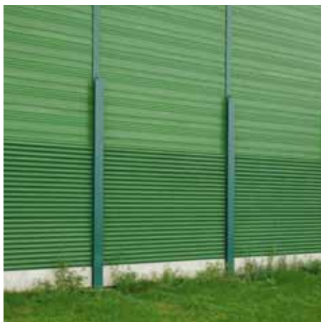
Panele SEA jako stabilna podstawa ekranu akustycznego w miejscu gdzie pożądana jest wysoka pochłaniałość dźwięku.
