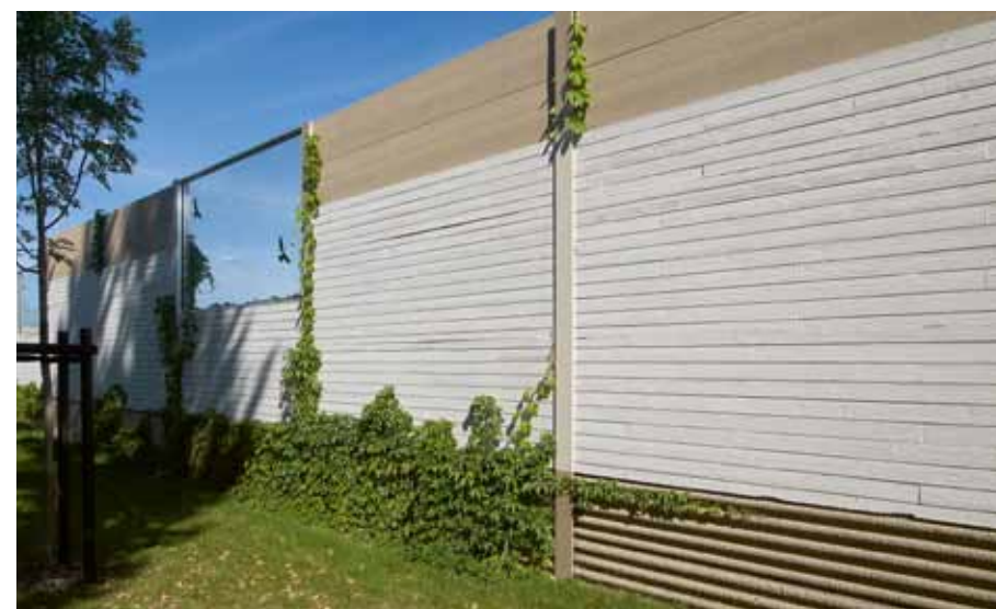
Strukturalna powierzchnia tylnej części paneli akustycznych nie tylko podnosi estetykę, ale zapewnia również dobrą przyczepność dla roślin.
