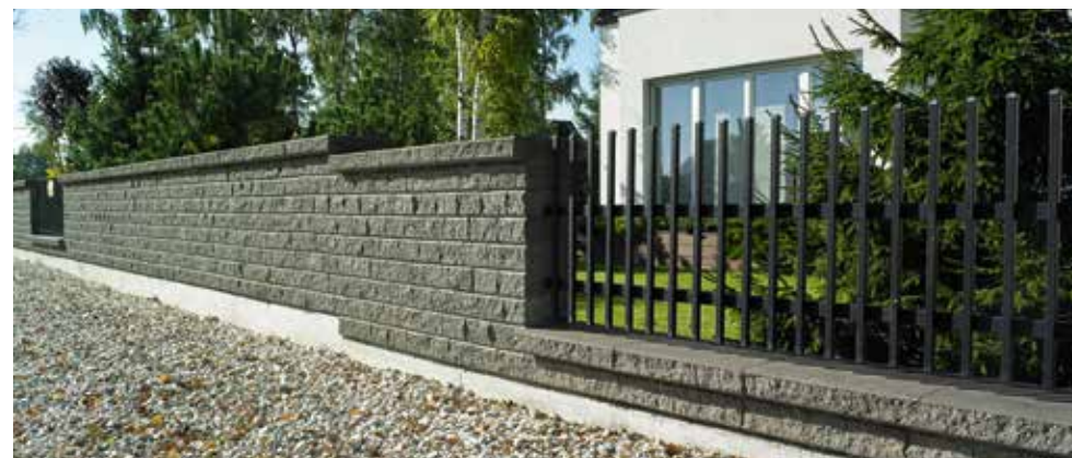
■ Nieprawidłowe posadowienie muru. Fundament widoczny ponad poziomem ułożonej nawierzchni.
